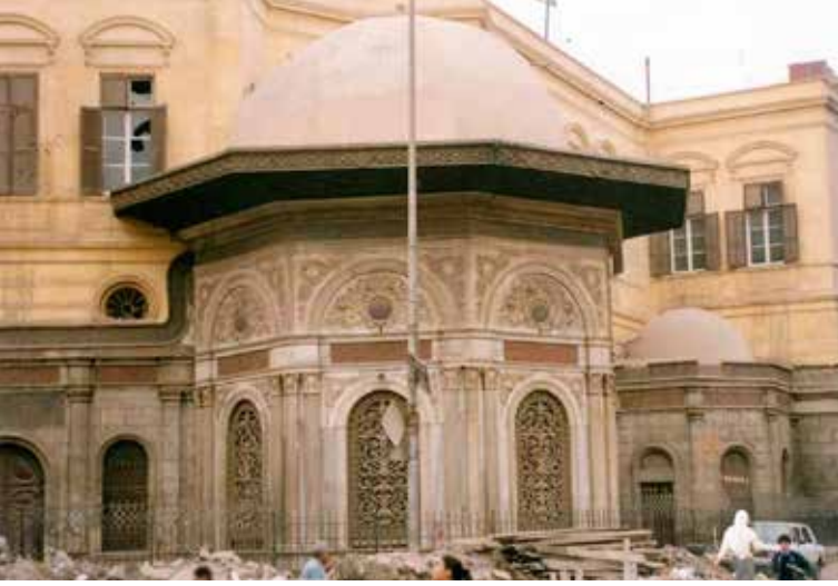
Resim 8- Köşedeki Sebilin Görünüşü
