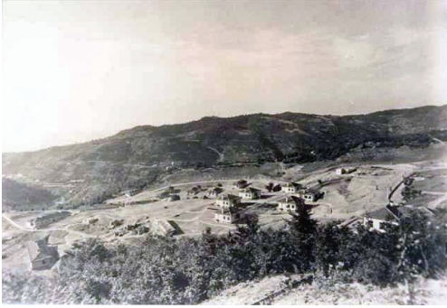
Kılıç Mahallesi'nin kuruluşu: İşçi evleri.
